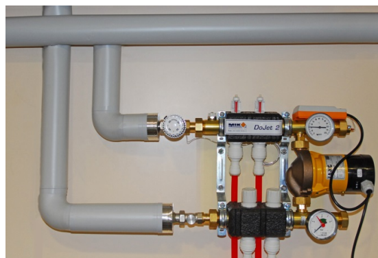
Abb. 10b: Richtig - alle Rohre des Systems wurden
